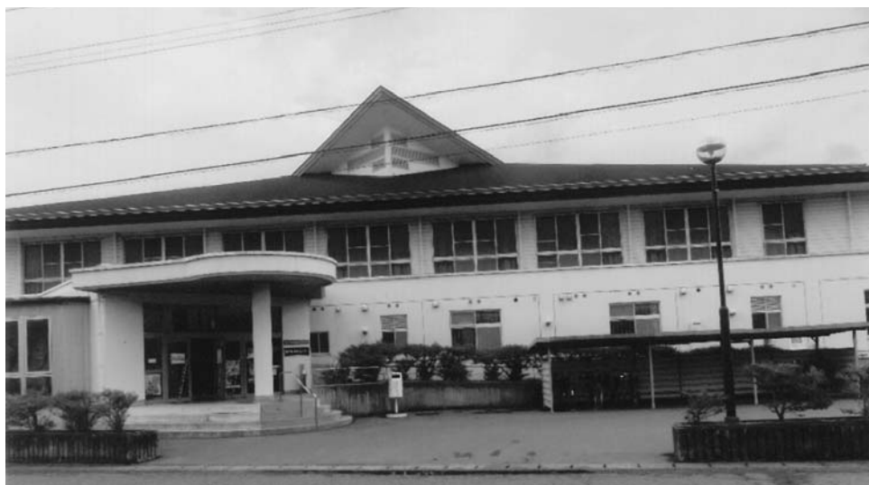
藍住町体育センター（2024年3月8日撮影）
